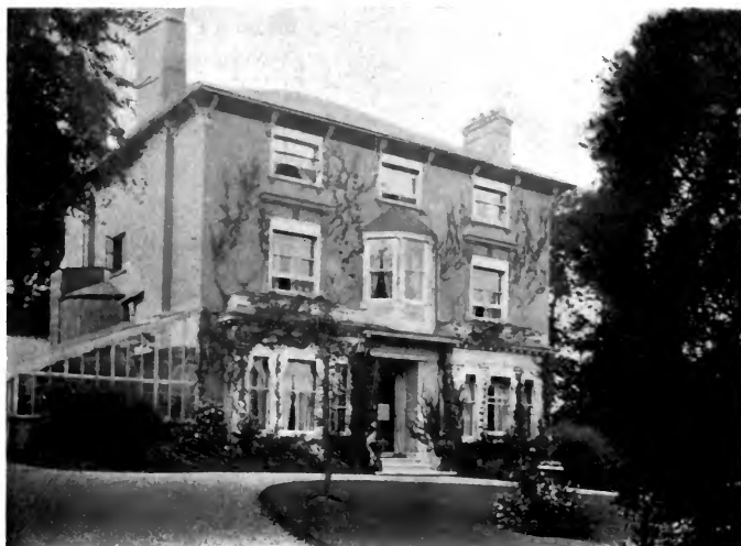
CAMBRIDGE HOUSE, WIMBLEDON.
